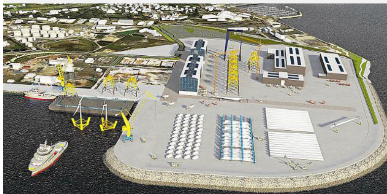
Travaux en cours pour la réalisation d'un polder sur le port de Brest visant à attirer les activités liées aux énergies marines
