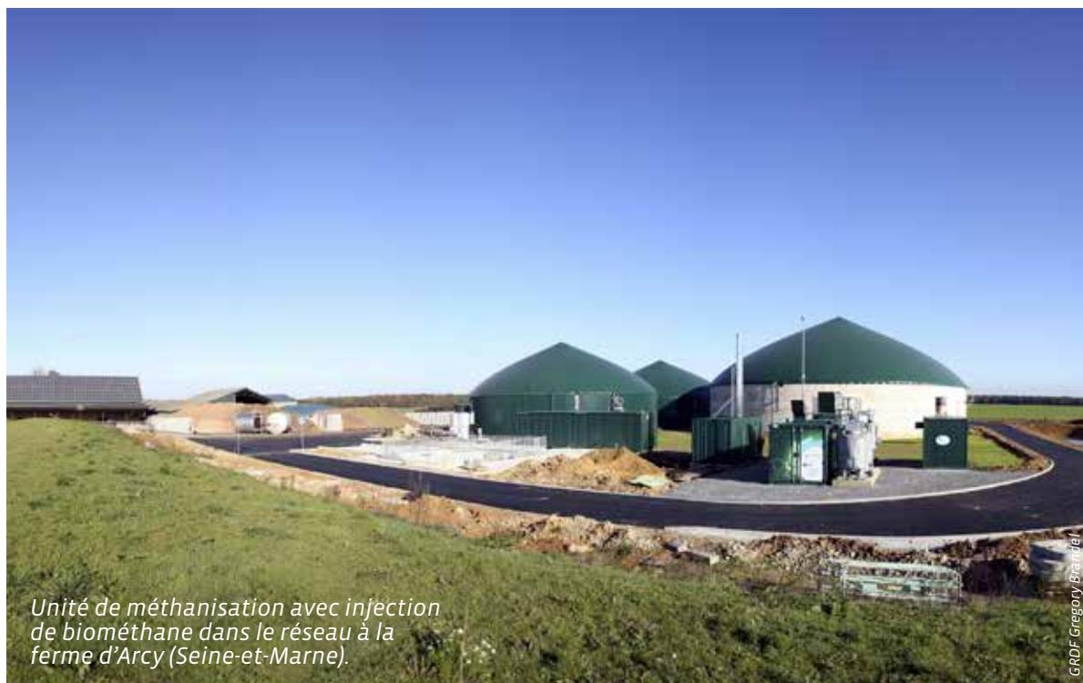
*Unité de méthanisation avec injection de biométhane dans le réseau à la ferme d'Arcy (Seine-et-Marne).*
